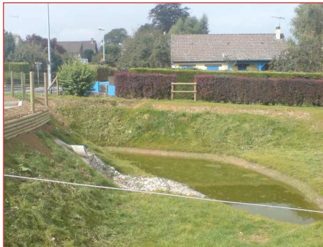
La mare tampon est à situer dans un axe de passage ou de concentration des écoulements.
